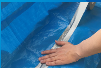
ビニールシート等の繋ぎ
