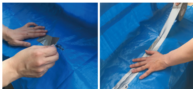
ブルーシート破れ補修、シートの同士の繋ぎに
