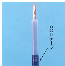
①ケーブルの段はぎ及び ACPテープ巻き
