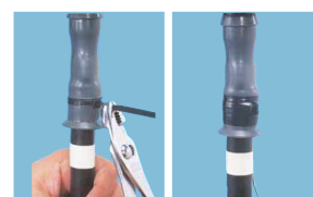
⑤締め付けバンド、 保護テープ巻き作業
