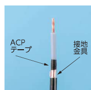
②ACPテープ巻き 接地金具の取り付け
