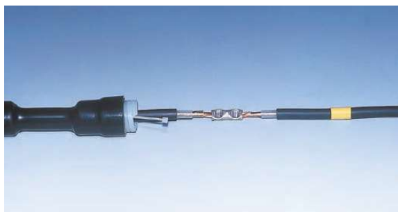
③B形圧着スリーブを圧着します。圧着後マーキングをします。
