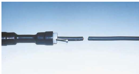
①耐火プルフィットチューブをケーブルに挿入します。
