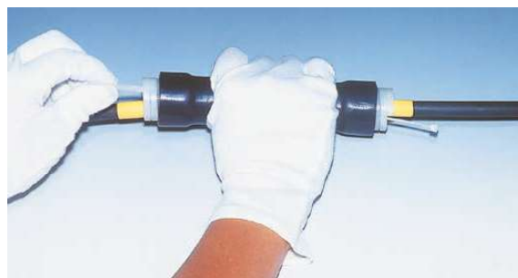
⑦チューブ中央部をしっかりと押さえながら、コア紐を引き抜きます。
