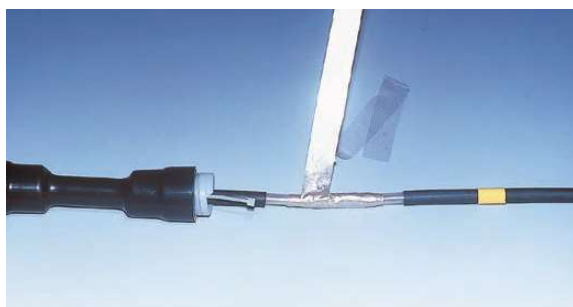
④スリーブ上に耐火テープを巻き付けます。
