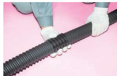
③ エフレックスの突き合わせが中央に来るようにアクアフィットを逆方向にねじ戻して接続施工完了です。
