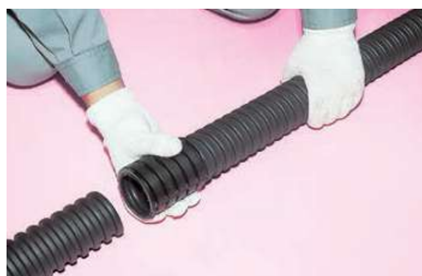
② 他方のエフレックスを突き合わせます。
