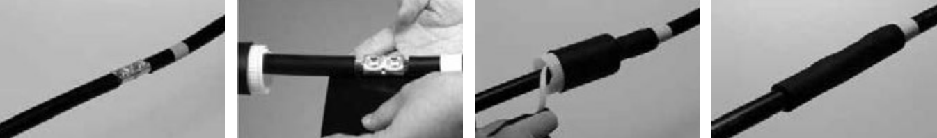
1. 導体を接続する 2. 絶縁シートを巻く 3. コアのリボンを引き抜く 4. 作業完了
