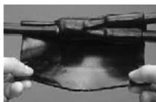
2. 絶縁パテシート（大）（小）の 巻き付け分岐線の結束
