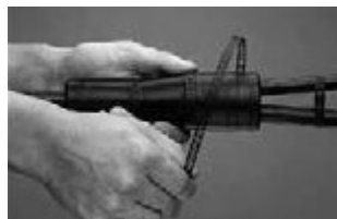
4. 分岐カバーを結束し完成 (2分岐加工可能)
