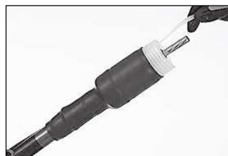
3. 端末外被の装着。 ※ケーブルシース部の防水処理にテープ巻きが不要です。
