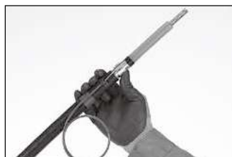
1. 接地クランプの取付け。
